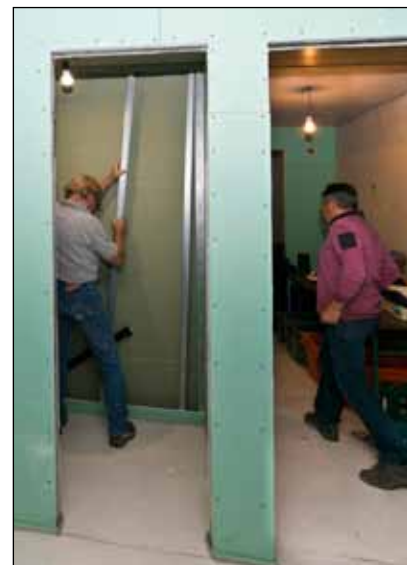
Außenansicht Clubhaus (oben), der Innenausbau schreitet voran (unten)
