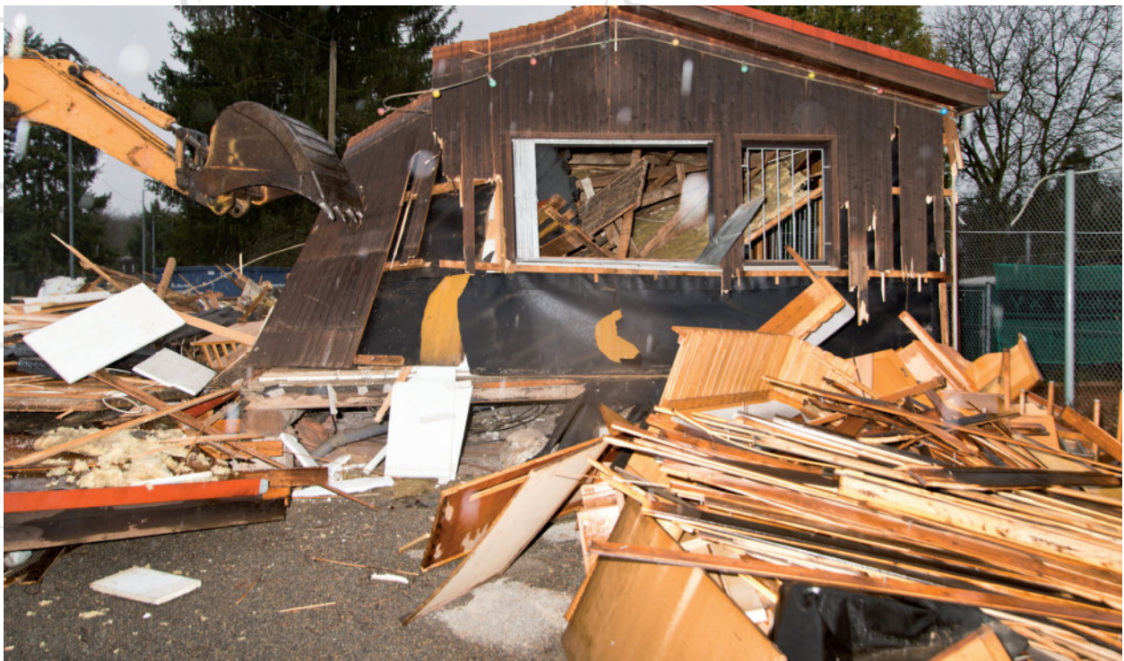
Schweres Gerät zerlegt die alte Tennishütte
